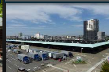
船橋市地方卸売市場
